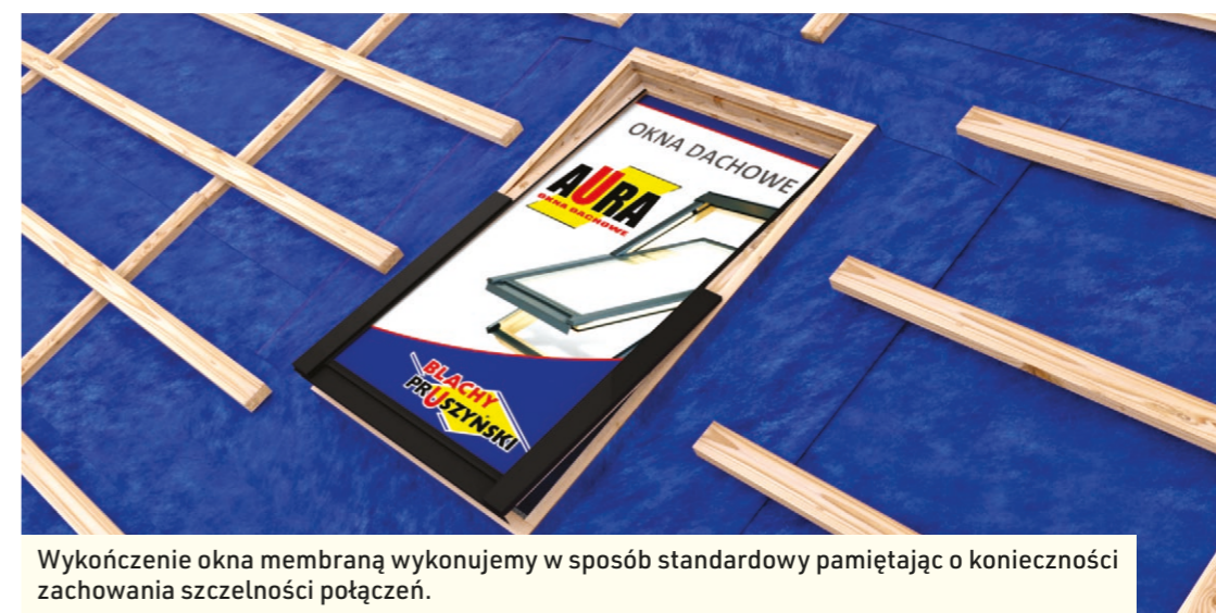
Podkonstrukcja okna dachowego
