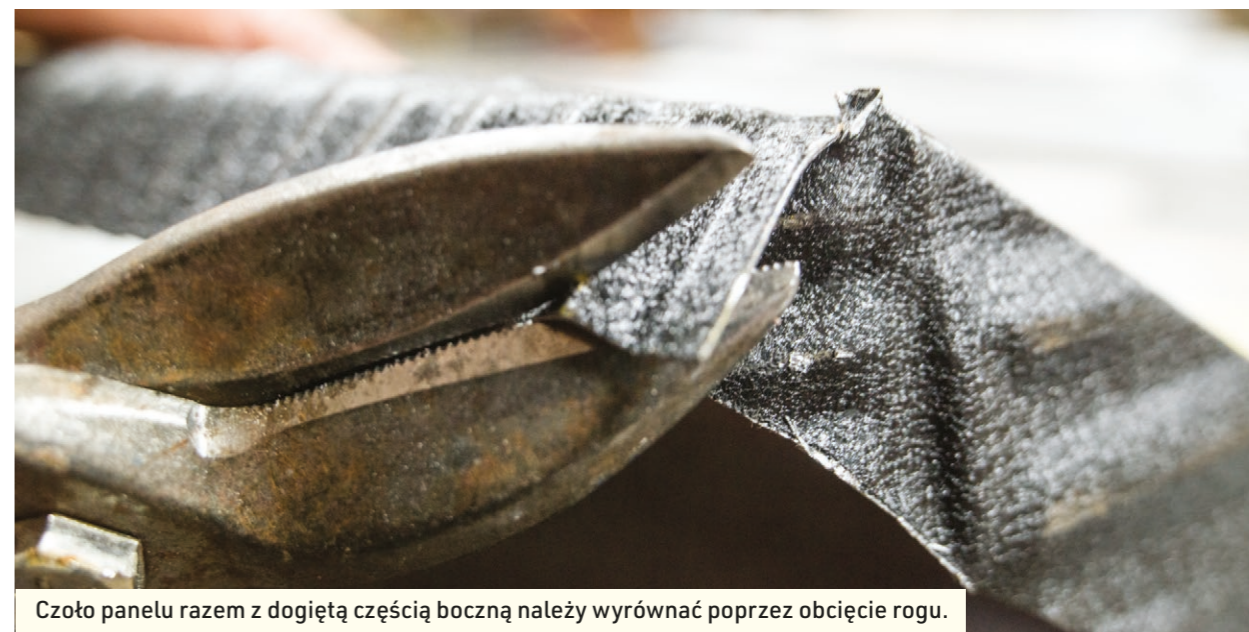
Niedociągnięcia można poprawić za pomocą szczypiec.
