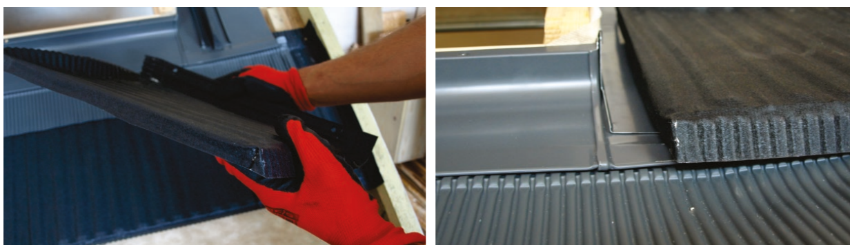
Zamontowane okno dachowe.
