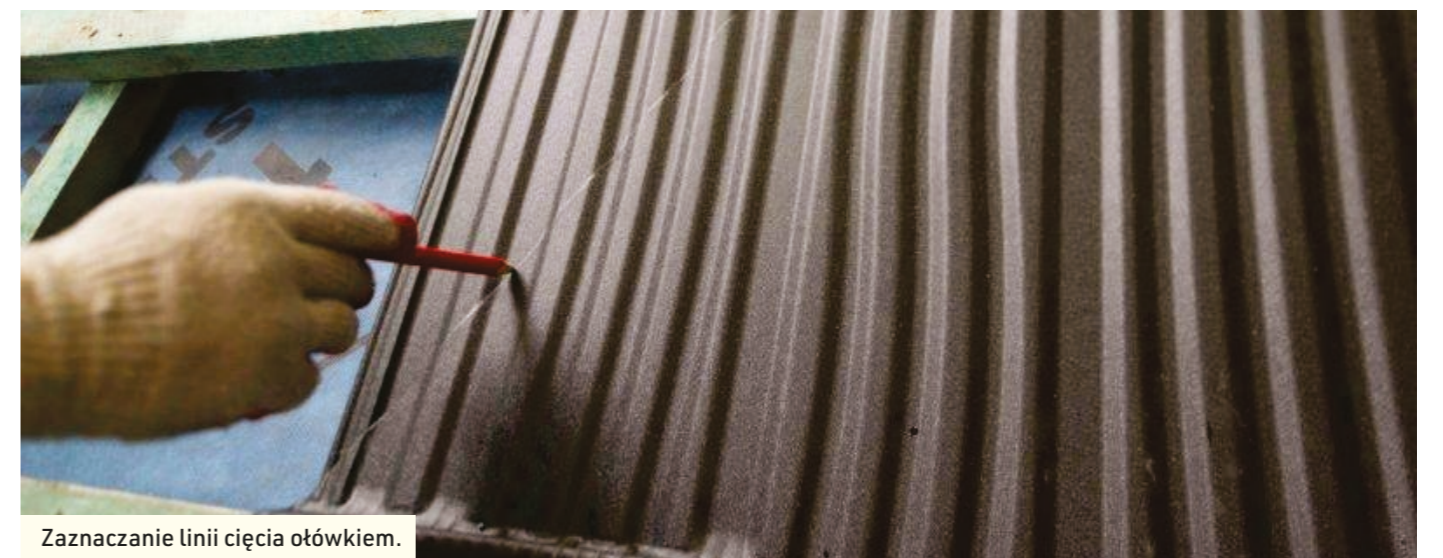
Wykonywanie pomiarów konstrukcji w celu docięcia paneli koszowych.
